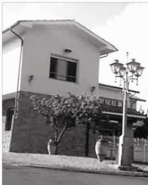
Aspecto que muestra la Residencia desde el exterior.
